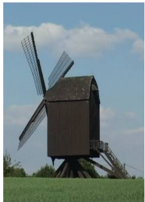
Die Tönisberger Mühle ist vom Bautyp Kasten-Mühle bzw. Bockwindmühle.
